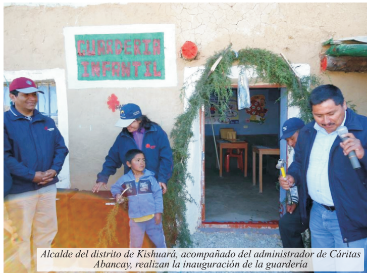
Faenas previas a la construcción del local comunal
