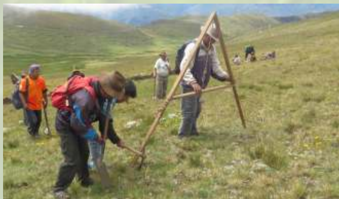
Marcado de suelo para la apertura de zanjás
