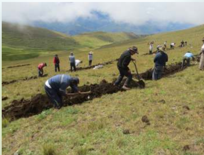
Apertura de zanjás de infiltración en las alturas de la comunidad de Ccocha - Curahuasi
